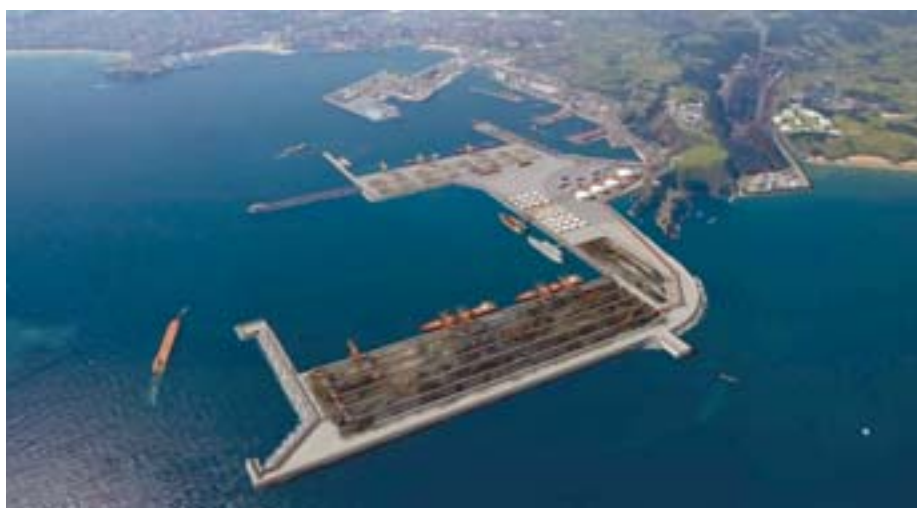
► Panorámica de la ampliación del puerto de El Musel en Gijón.
