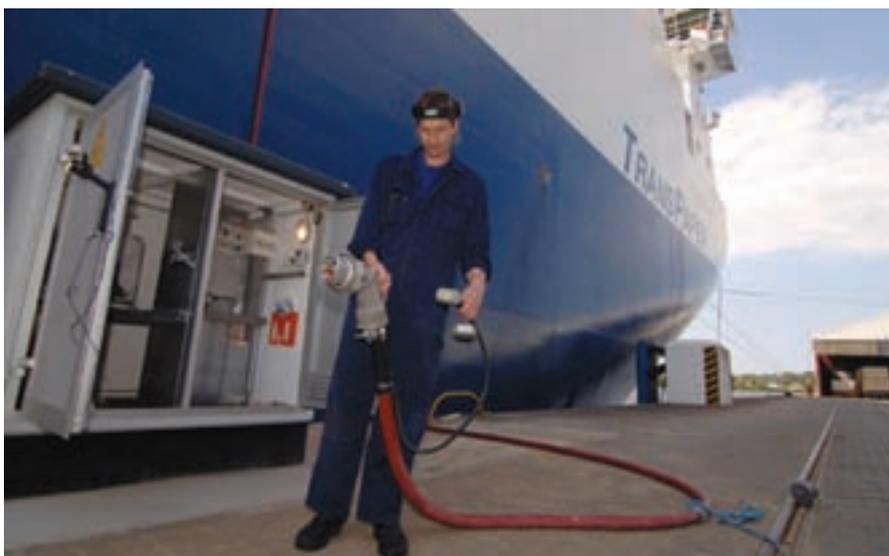
▲ Enclavamientos para conexión eléctrica de buques atracados (de 5 Kw y 10 Kw) puestos en servicio en los muelles del puerto de Lübeck (Alemania). El sistema, adoptado por diversas autoridades portuarias, evita las emisiones de los motores auxiliares durante la estancia en puerto.
