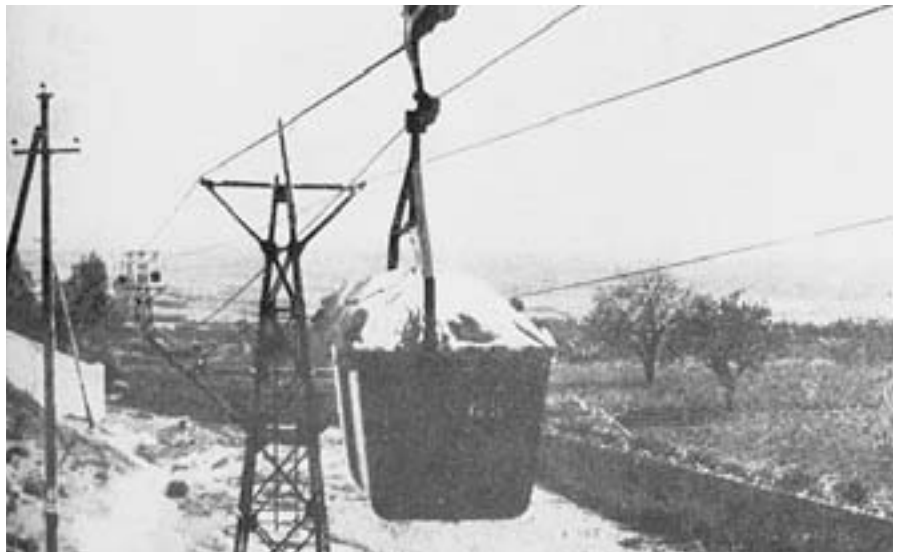
▲ Vagonetas y castilletes recorrían los 40 kilómetros que separan Dúrcal del puerto de Motril.
