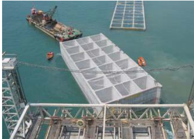
▲ Instalación de los cajones que conforman el muelle de Las Azucenas.
