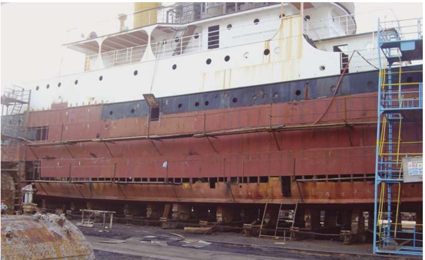
▲ Los trabajos de restauración se encuentran muy avanzados.
