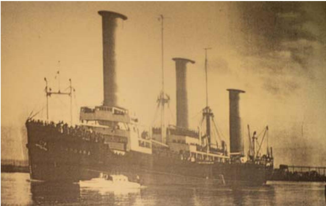
Figura 6. El rotor-ship "Barbara", dotado de tres cilindros rotatorios en lugar de los dos del "Buckau" y construido para la Compañía Naviera Hamburgo-Amerika Linie tras el éxito del primer prototipo. Fuente: <http://www.rafoeg.de>.
