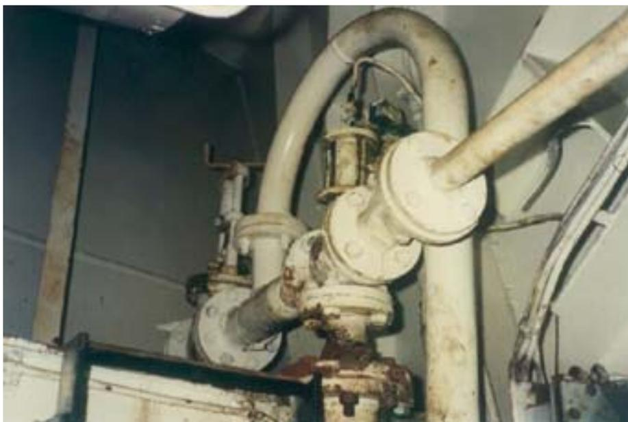
> Bypass en la descarga al costado después de la válvula de tres vías del equipo.
