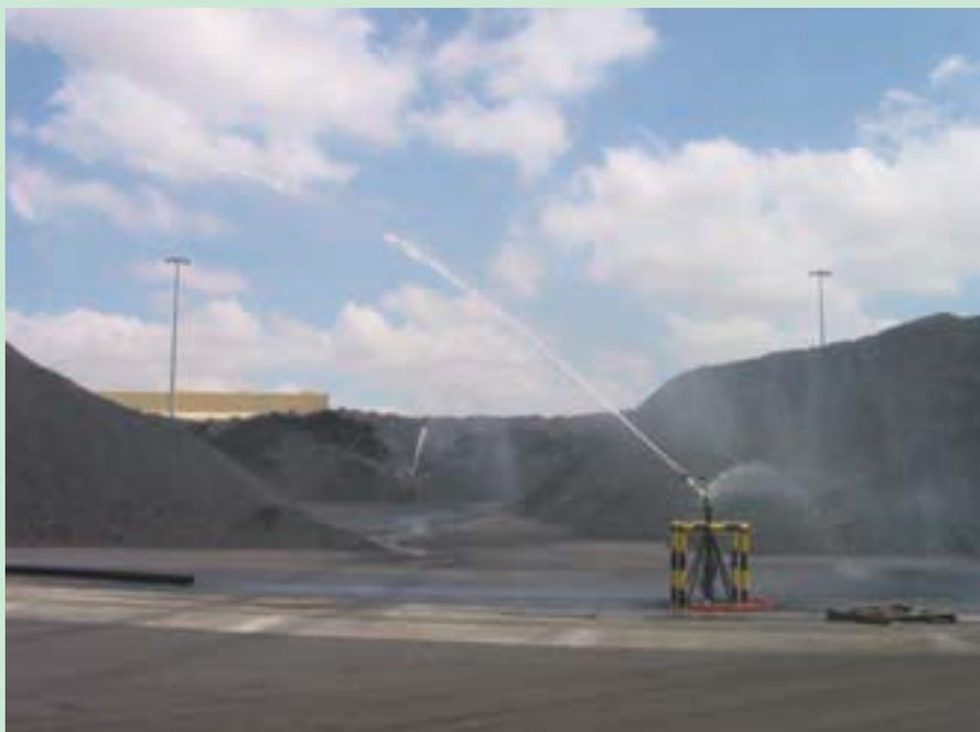
▲ El riego de determinados graneles, como el carbón, es uno de los sistemas más eficaces para disminuir la presencia de partículas en la atmósfera durante la manipulación o en caso de viento. El puerto de Huelva dispone de una red de aspersores fija para esta actuación ambiental.
