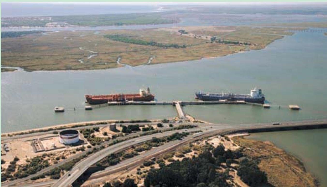
▲ Muelle de Petroleros en Punta Arenillas, en la confluencia del Tinto y del Odiel. Con calados de 13 metros y 560 metros de longitud, dispone de dos atraques con instalaciones especiales para fluidos.
