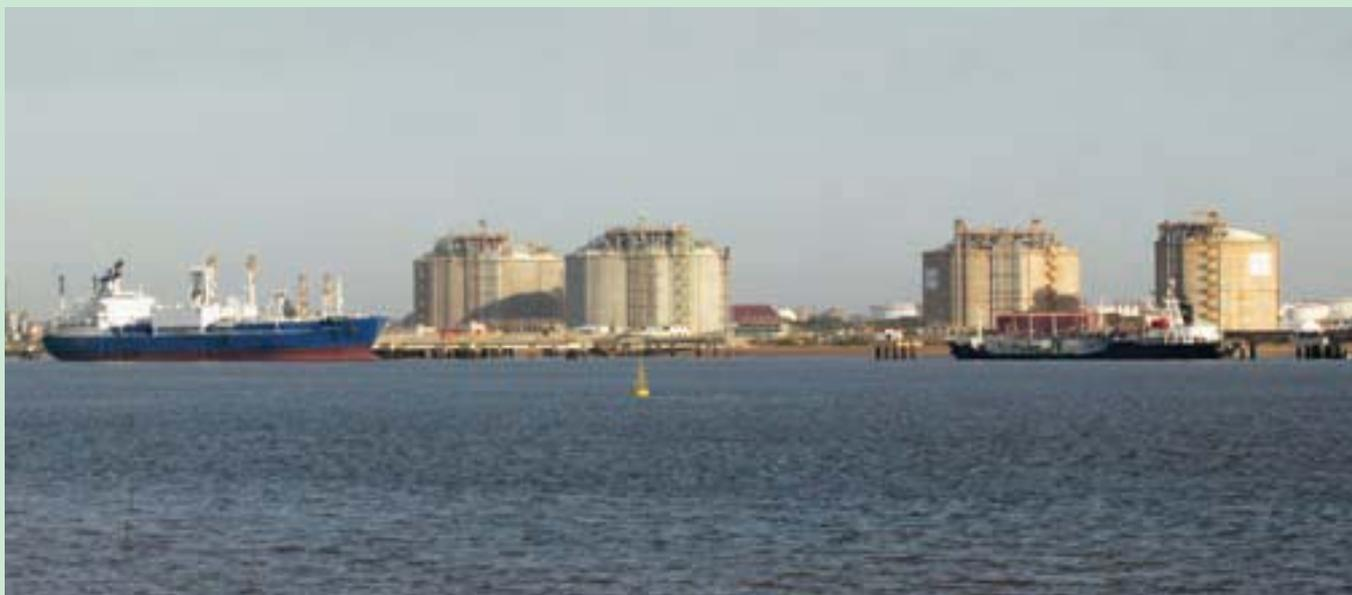
▲ Un buque metanero descarga gas natural licuado en la terminal de ENAGAS. La planta de regasificación de Huelva entró en servicio en 1988, siendo el LNG "Isabella" el encargado de descargar el primer gas natural procedente de Argelia. La capacidad conjunta de almacenaje de los cuatro tanques es de 465.000 metros cúbicos, estando previsto que en 2010 se complete un quinto tanque de 150.000 metros cúbicos.
